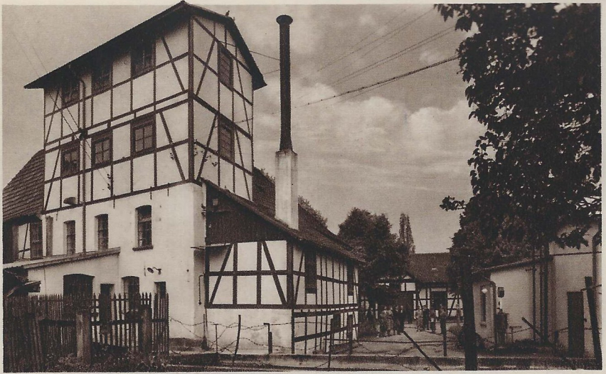
Mühle mit Turbinenanlage und Bäckerei
